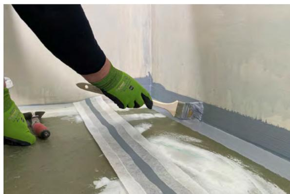
hasta lograr un color uniforme. Por el contraste resultante con la primera capa podremos observar los defectos o imperfecciones que puedan aparecer en la primera capa. El espesor de la segunda capa debe ser de al menos 4 mm.
